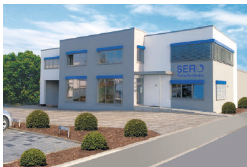
Центральный офис, завод по производству насосов и испытательная лаборатория в Меккенхайме
